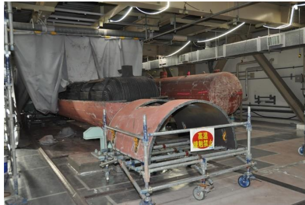
給水加熱器（タービン建物3階）の解体 （2023年11月末時点）
