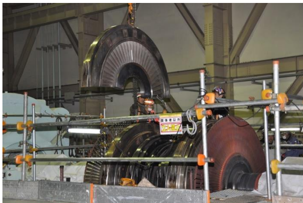
タービン（タービン建物3階）の解体 （2023年11月末時点）
