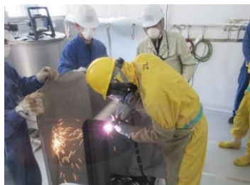
解体技術研修（プラズマ切断）の様子
